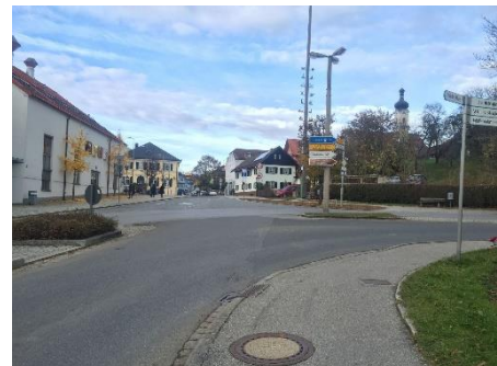
Blick von Süden auf Knotenpunkt
